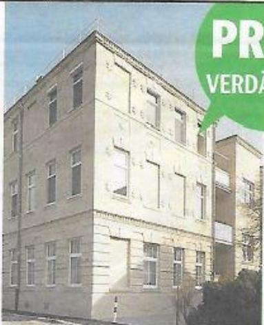
**Das „Vereinshaus“ Strasshof an der Nordbahn** in Niederösterreich, Baujahr 1909, wurde 2014 saniert. Die alte Sichtziegelfassade wurde dabei wieder auf Hochglanz gebracht und nicht hinter einer dicken Schicht aus Wärmedämmung versteckt.
