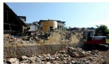
Die Abrissarbeiten des Stadels in Emmersdorf sind im Gange
