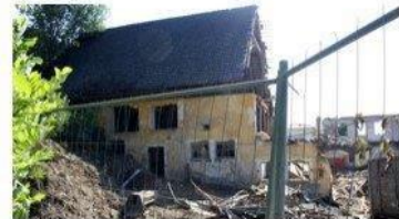
Seitenansicht des Abrisses des Emmerdorfer Stadels
