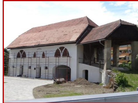
und NACH der Renovierung
