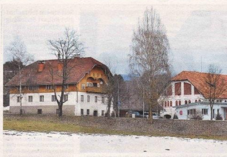
Achtung Einsturzgefahr! Der Staberhof in Waiern muss umgehend geräumt werden
